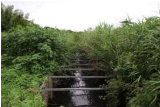
谷津中央を流れる水路（毘沙門天堂近く）
