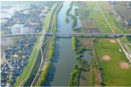
写真 江戸川におけるワンド掘削状況
